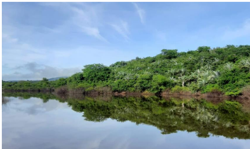
Figura 1: Represa da Barragem Grande, Santa Inês-BA.
