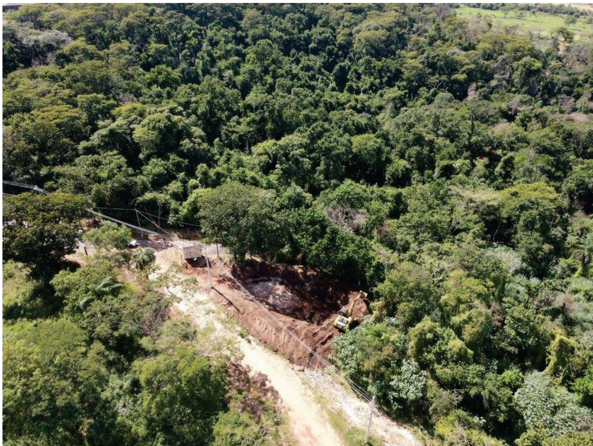
Figura 2 - Construção de um tanque de contenção e infiltração da água pluvial.
