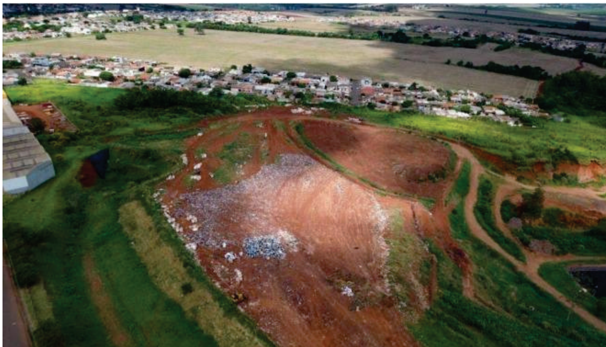
Figura 01 – Aterro Sanitário do município de Arapongas.
