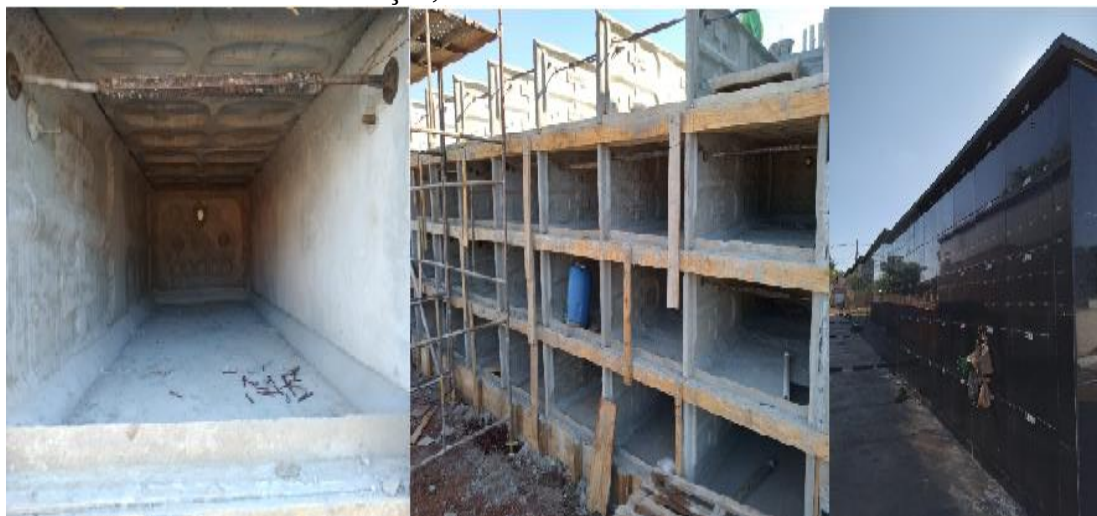
Figura 1: Sistema vertical em implantação no Cemitério Municipal Jardim da Saudade - Londrina, à esquerda: lóculo para inumação; ao centro: estrutura vertical em construção; à direita: ala vertical finalizada e em uso.
